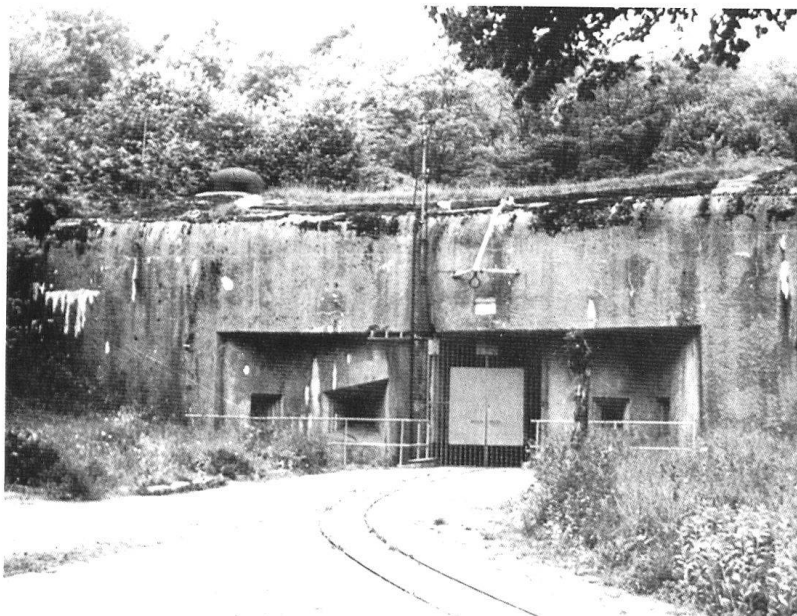
Entrée « Munitions » de l'ouvrage de Rochonvillers.
