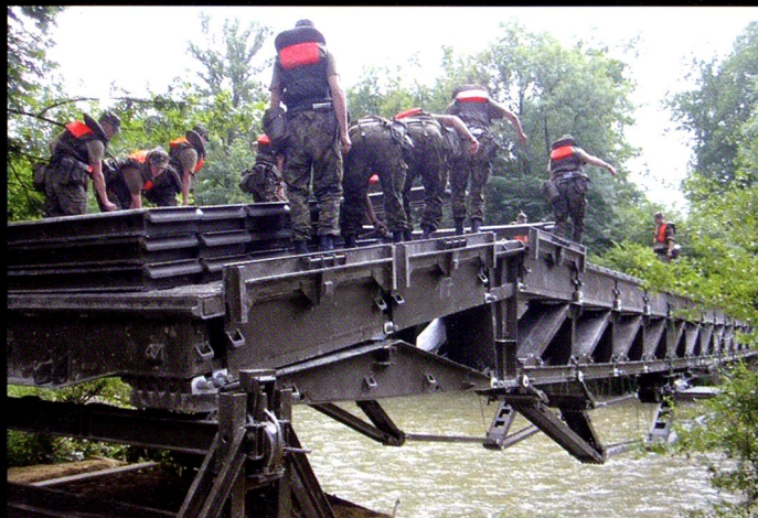
Le pont fixe 69 est lent à mettre en œuvre et nécessite une main d'œuvre importante ; sa longueur peut aller jusqu'à 48 mètres. En raison de son âge, le pont fixe 69 n'est utilisé aujourd'hui qu'avec de nombreuses servitudes : 29,33 mètres et 28 tonnes de charge au maximum.
