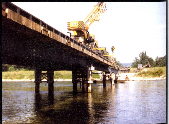
Le pont à poutrelles d'acier (PPA) nécessite de gros moyens de mise en œuvre. Sa portée peut atteindre 142 mètres.
