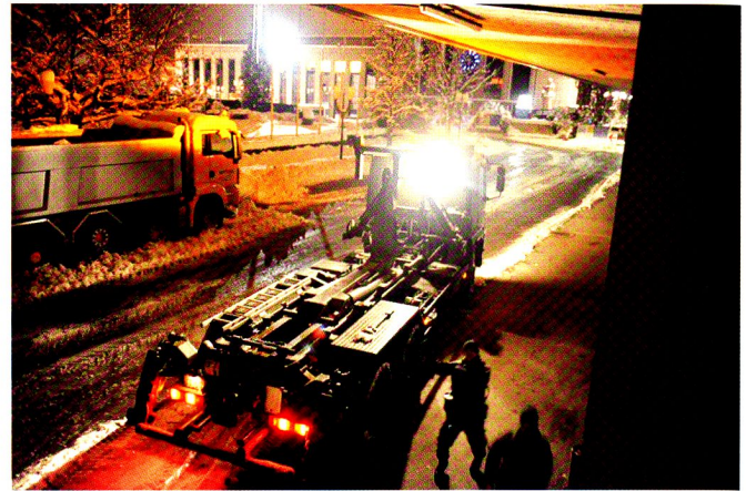
...et installation le 2.12.2010 à 0500 devant la Halle 13 du Palais de Beaulieu.
