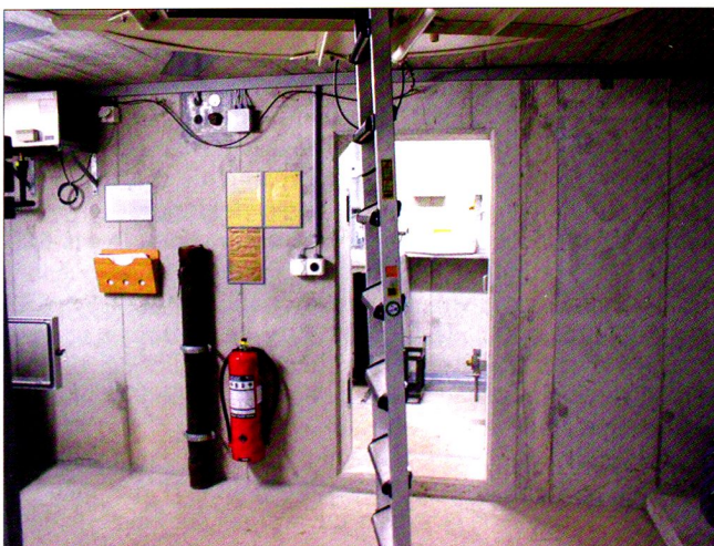
L'échelle amovible permettant d'accéder à la tourelle depuis le local central de l'ouvrage.
