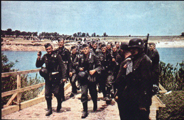
Progression d'une unité d'infanterie sur une passerelle construite par le génie.
