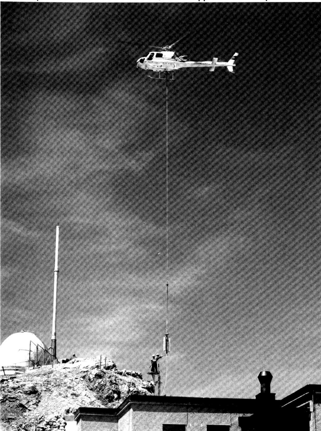
Mise en place d'une antenne Link 16, avec l'appui d'un hélicoptère.
