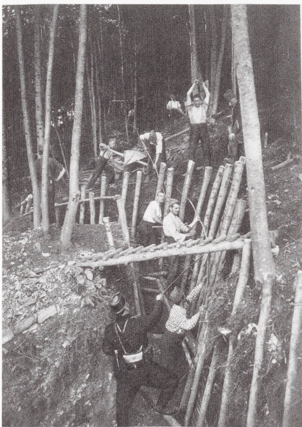
Aménagement d'une tranchée. Les hommes portent une tenue partiellement civile.
