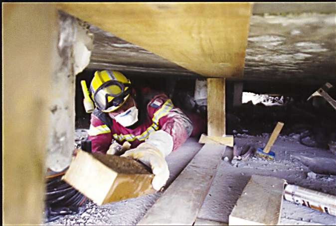
Un sapeur-pompier en train d'étayer une plaque de béton dans un bâtiment qui s'est effondré. La collaboration entre tous les acteurs est nécessaire afin d'accroître l'efficacité d'une intervention. Photo © Fabian Gürber / Aldo Ellena / Centre des médias électroniques.
