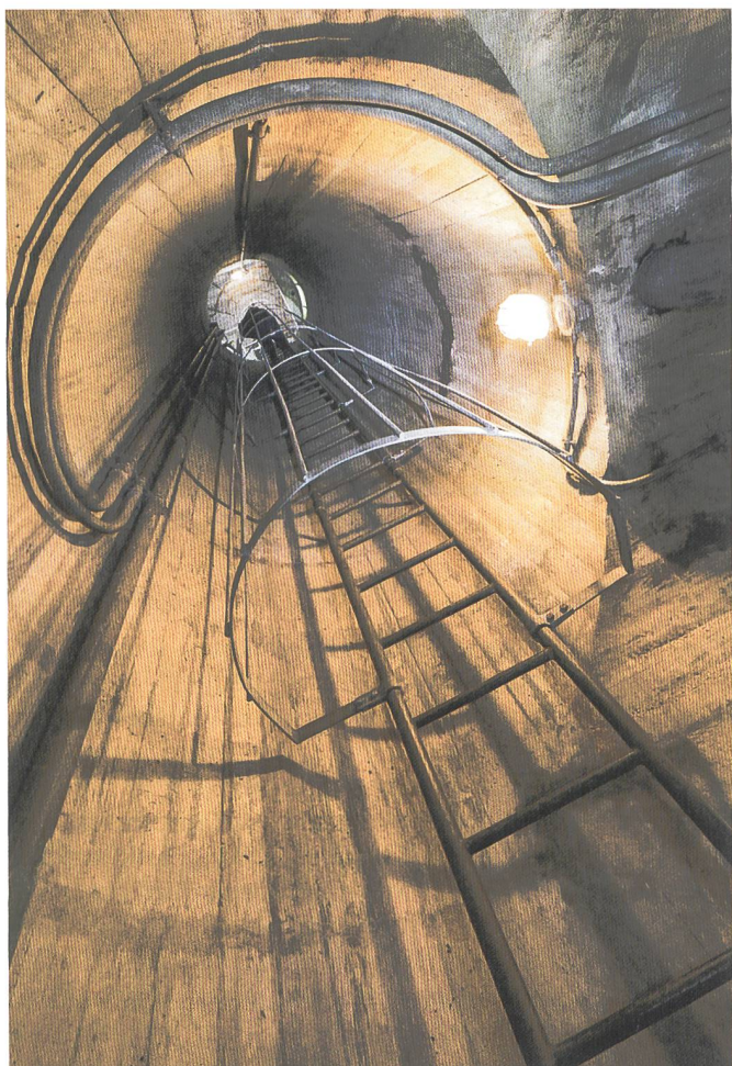
Fortin du Chételat : Le puits qui mène à la sortie de secours. Photo © Michael Peuckert.
