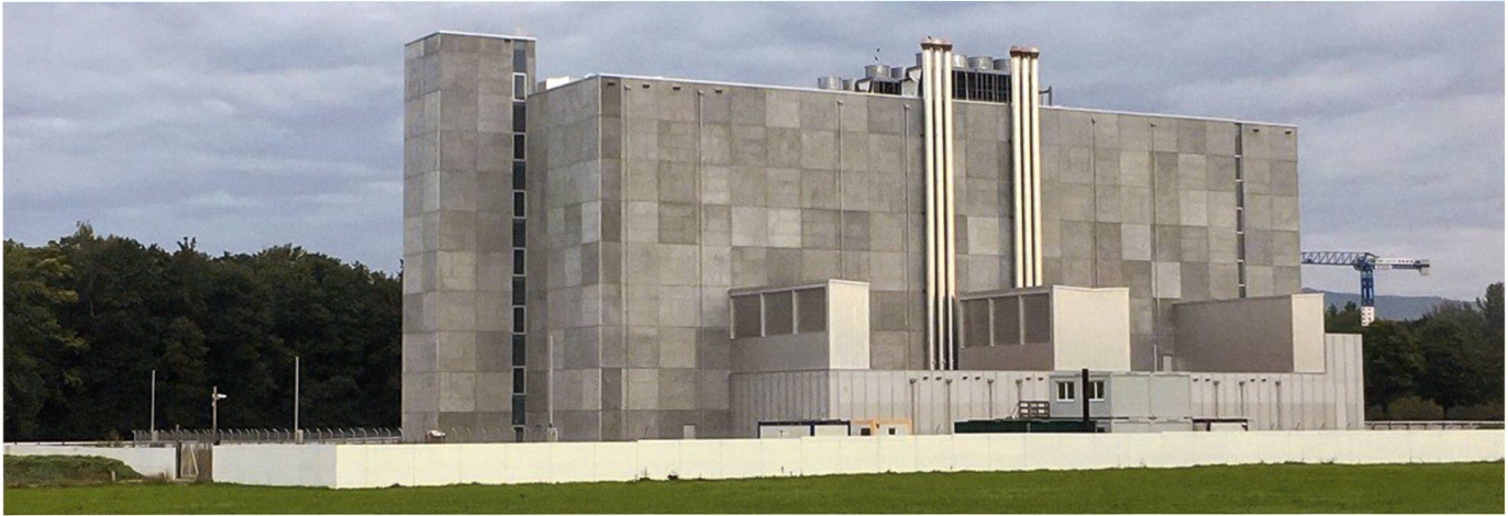
Le centre de calcul de Frauenfeld est l'un des éléments visibles du programme FITANIA, avec lequel la future infrastructure numérique de l'armée sera réalisée.
