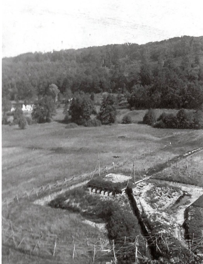
Le poste d'observation Nord du Largin.
