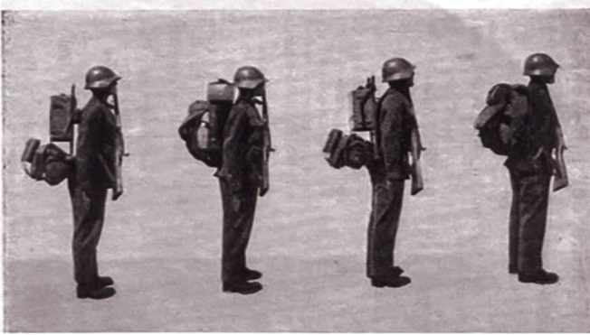
Figure 3: Radio de commandement tactique en Suisse: Patrouille radio avec 4 pionniers: chef de station, opérateur radio, actionneur de la manivelle de la dynamo, secrétaire. Communication (lente) à l'aide du code Morse.
