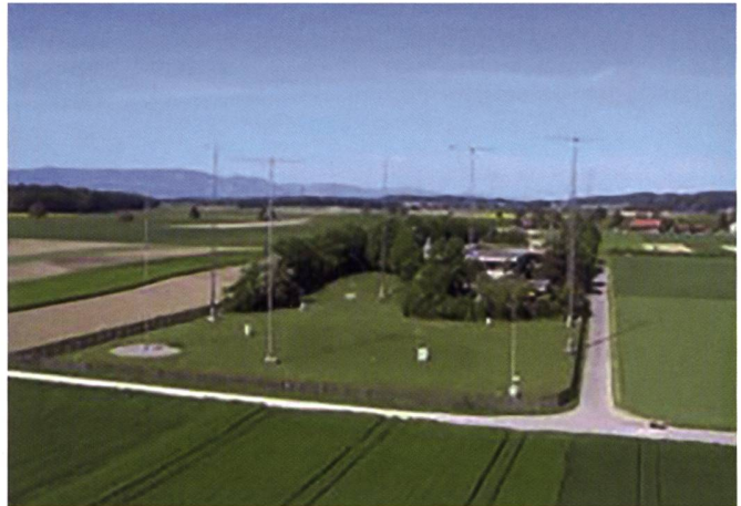
Figure 20: Centrale de réception de la radio des ambassades sise à Murain près d'Ersigen BE.
