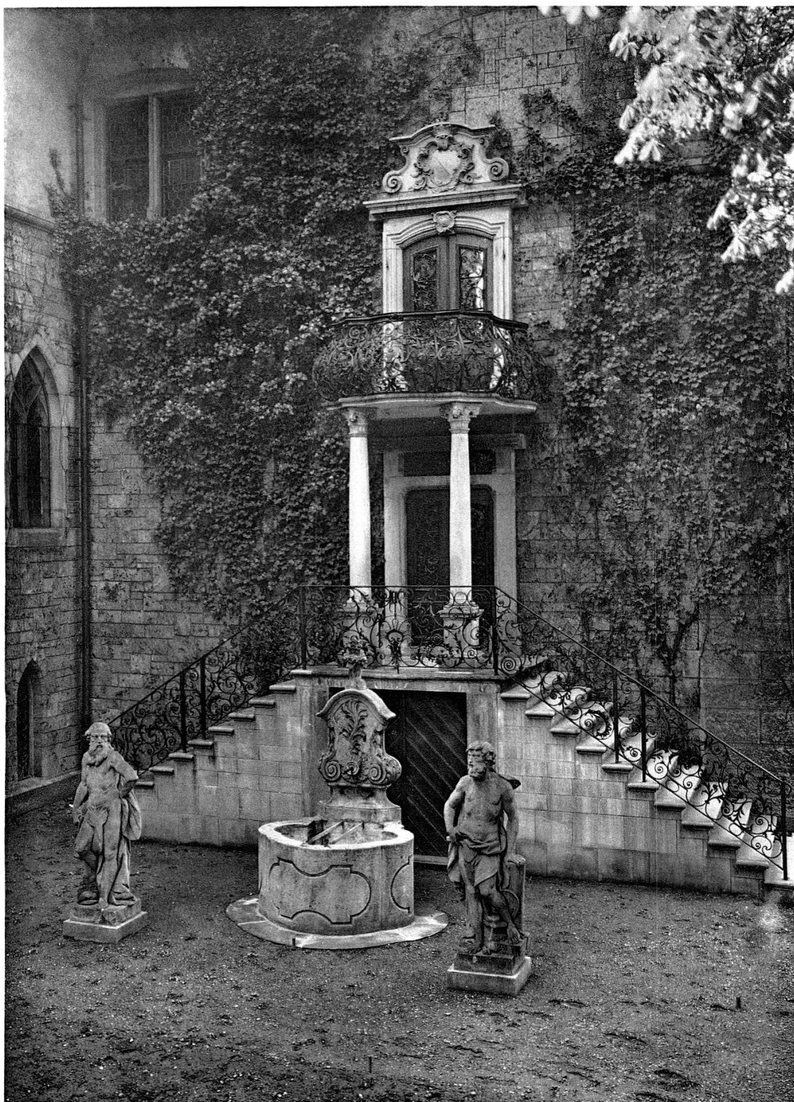
Escalier et balcon provenant du „Seehof“ à Meilen, 1767
