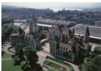
Le Musée national et le Platzspitz avant les travaux de rénovation et d'agrandissement.
