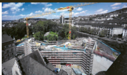
Progression des travaux de construction du nouveau bâtiment.
