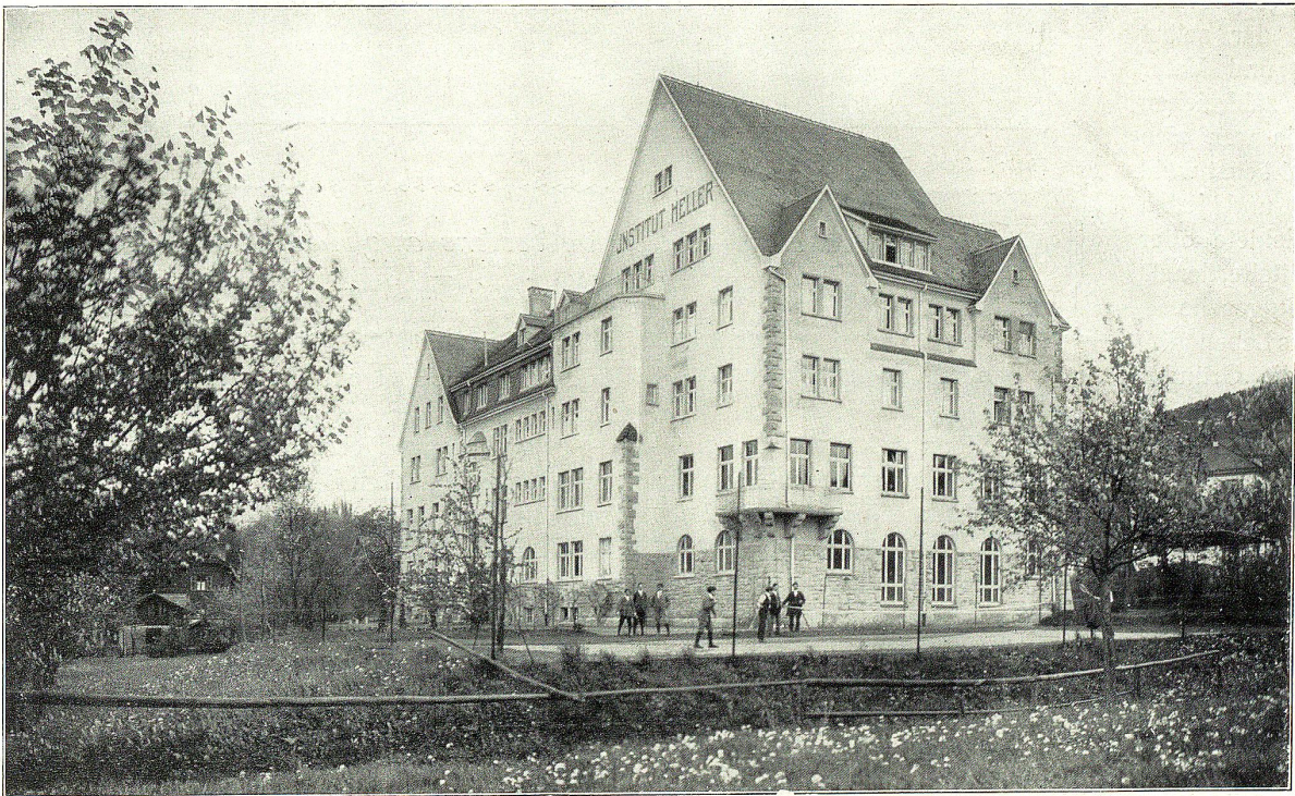
Total-Ansicht des Institutsgebäudes.
