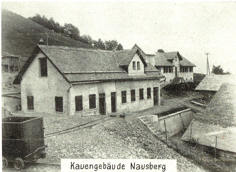
Abbildung 12. Das Kauenhaus. Als „Kaue“, „Kaukamm“, wird in der Bergmannsprache ein Werkzeug zum Loslösen des Erzes bezeichnet. Das Kauengebäude ist also in erweitertem Sinne ein Werkzeug- oder Material- gebäude.
