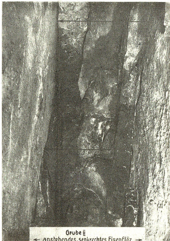
Abbildung 7. Das nahezu senkrecht stehende Erzflöz in Grube II.
