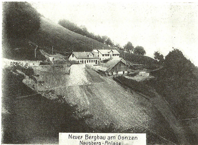
Abbildung 10. Die neuen Anlagen am Nausberg. Das Erzlager wird hier durch einen langen Stollen angefahren, dessen Ausgang oder Mund links neben den Gebäuden sichtbar ist (vergleiche auch Abbildung 11). Im Vordergrund der von dem Stollenbau herrührende grosse Schuttkegel.
