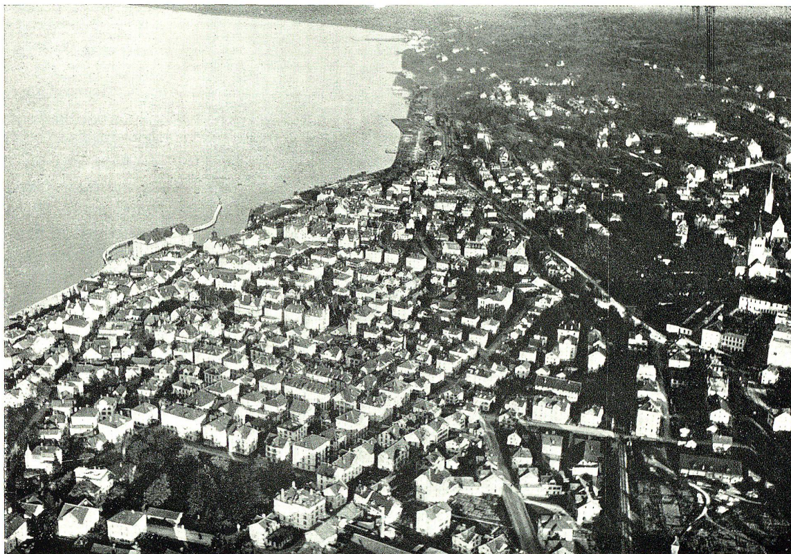
Flugstation Rorschach. Höhenaufnahme von W. Mittelholzer in St. Gallen.
