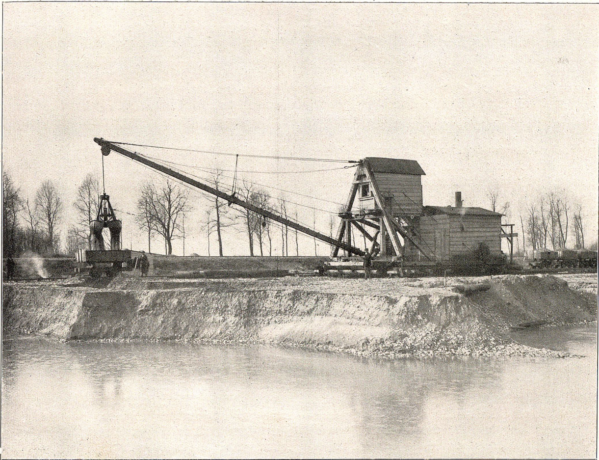
Abbildung 4a. Kiesgewinnung aus dem Rheine mit Greifbagger zum Herstellen der Dämme und Vorländer des Durchstiches; das Baggergut wird vom Greifer direkt in Rollwagen verladen.
