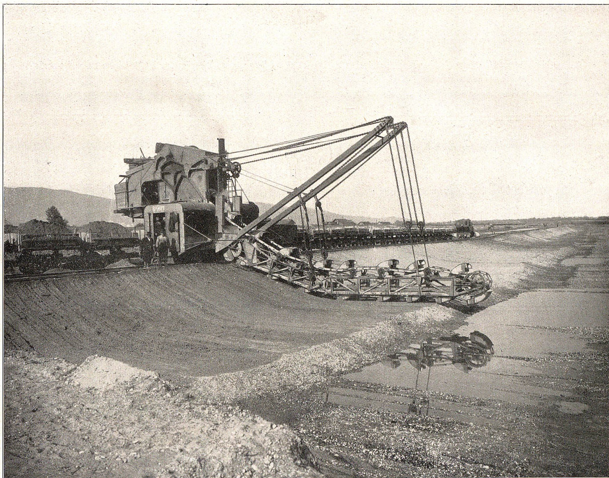
Abbildung 2. Aushub des Mittelgerinnes von hm 12–30 mit Eimerkettenbagger.
