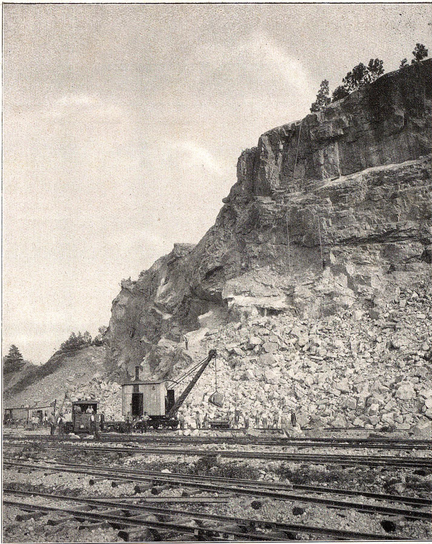
Abbildung 7. Steingewinnung für die Wuhrbauten im Steinbruche Kolbenstein bei Montlingen. Verladen der Steine mit Dampf- und Benzinkranen.
