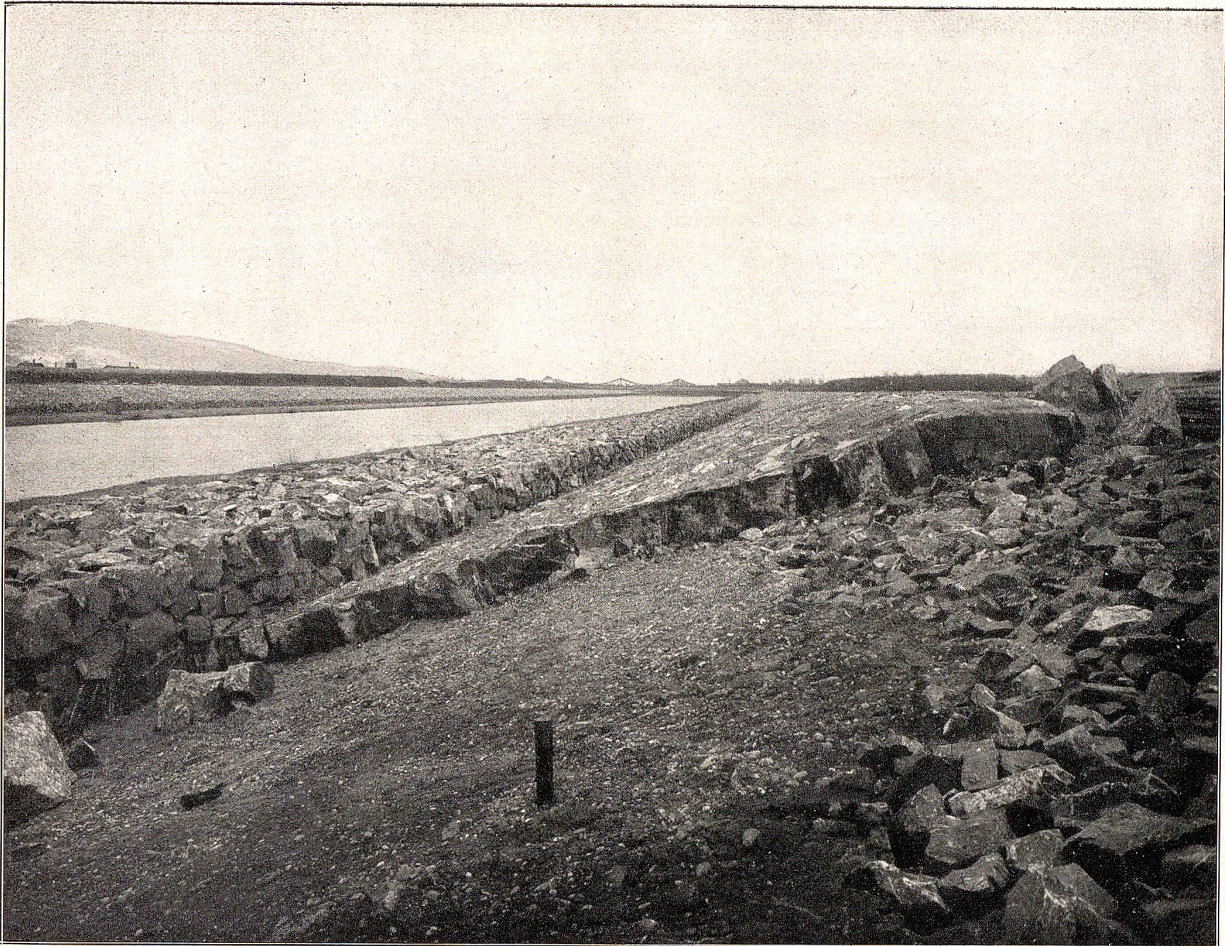
Abbildung 6. Steinbauten am rechtseitigen Ufer, in Ausführung begriffen.
