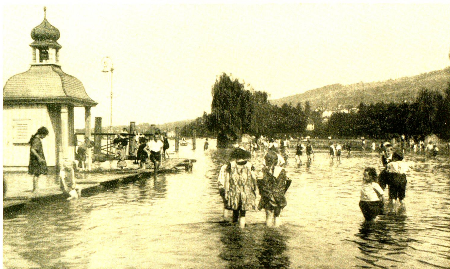
Ueberflutung des Kabisplatzes beim Signalhäuschen.
