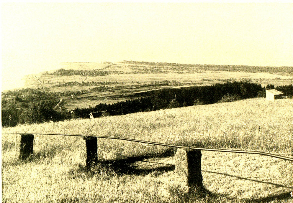
März 1926. Baugebiet und Flugplatz vor Beginn der Bauarbeiten.
