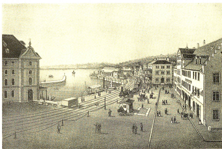
Fig. 8: Hafensplatz und neue Hafenanlage, 1869-72 erstellt.
