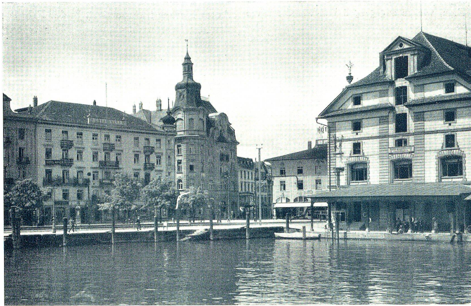
Rorschach, Hafen mit Kornhaus. (Phot. O. Moosbrugger, Rorschach.)
