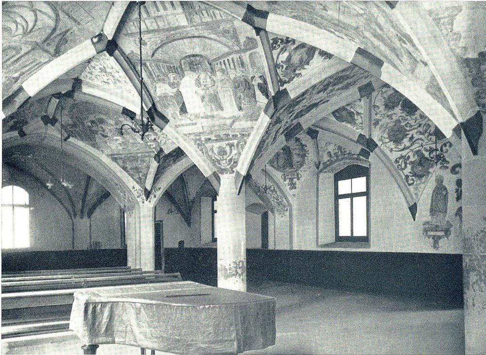
Gewölbmalerei im Kapellraum. Blick gegen Süden.
