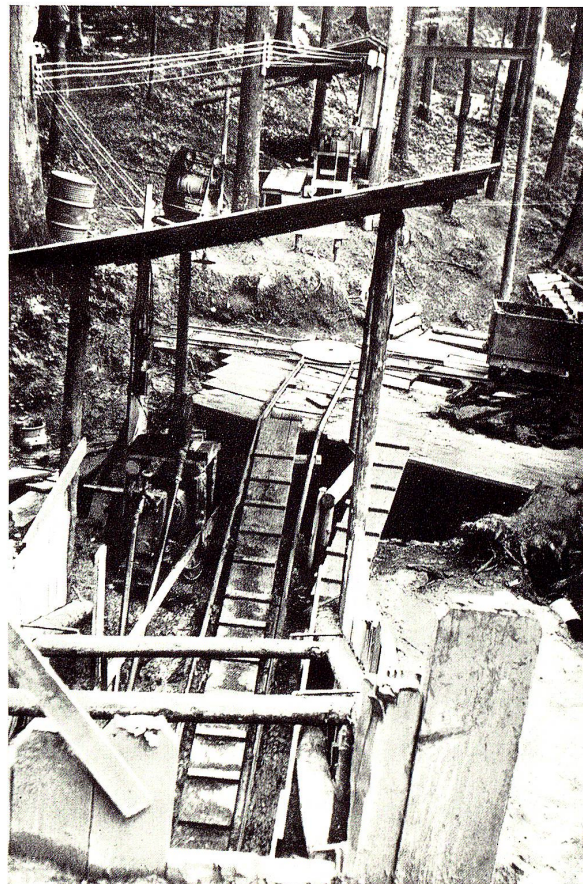
Abb. 5. Installationen des Stolleneinganges am Schwärzebach.
