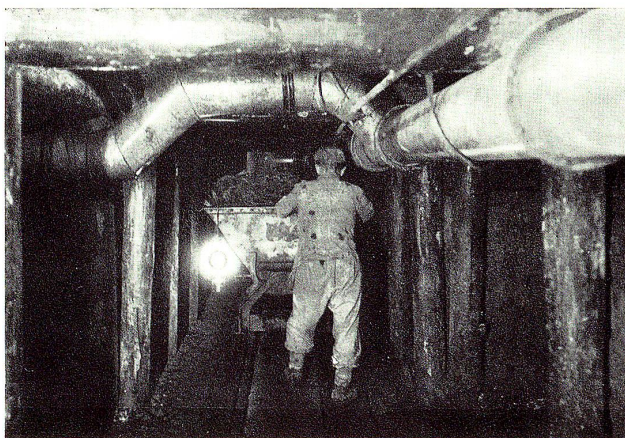
Abb. 3. Stollen mit Ventilationsrohren und Transportwagen.
