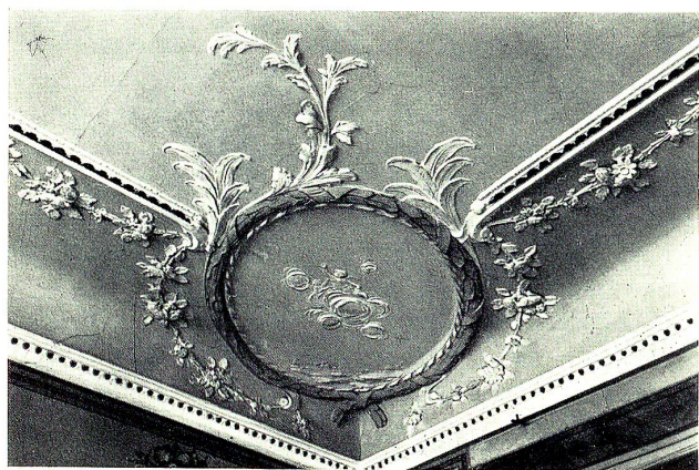
Teil der Stuckdecke im Sälehen des Hauses «Im Hof»
