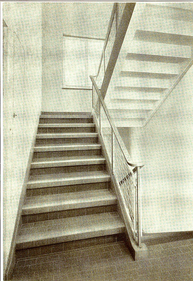
Max Pfister, Baubureau St.Gallen Neubauten an der Notkerstraße, Keramos-Treppe mit Tragwangen
