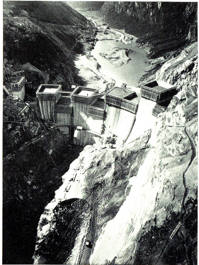
Talsole von Zervreila mit der Staumauer nach etwa 1 1/2 Jahren Bauzeit
