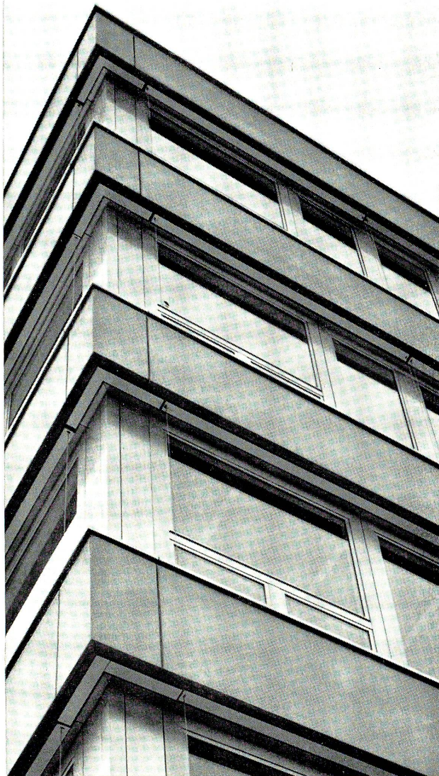
Vorfabrizierte Betonelemente Verwaltungsgebäude CMC, Schaffhausen Architekten: Walter Custer, Zürich Ernst Schmid, Schaffhausen Mitarbeiter: Fred Hochstraßer, Ulm
