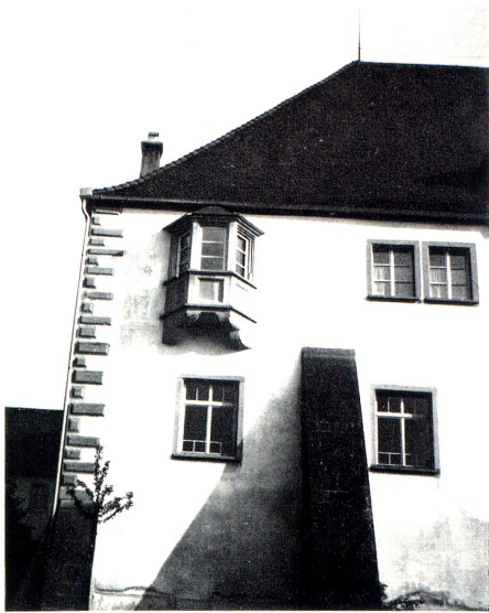
Nordflügel gegen Osten mit gefällig in die Augen fallendem Balkon , ein Beispiel für die ausgeglichene spätgotische Bauplanung und Flächengestaltung, die Stützmauer ein Notbehelf gegen die durch die Brandhitze aus dem Senkel geratene 8,10 m hohe Klostermauer, ein Beweis für das Flammenmeer wegen der ausgebauten Dachzimmer und der stärkeren Balken als beim zweiten Bau
