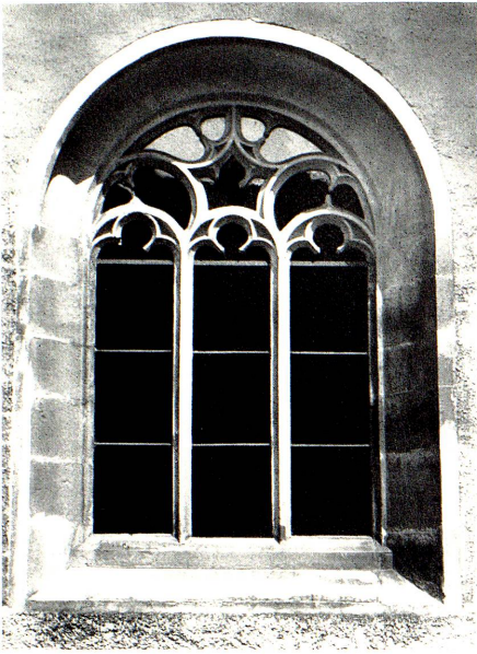
Maßwerkfenster, unter Abt Ulrich Rösch einfach erbaut mit nur einer Hohlkehle im Fensterbogen
