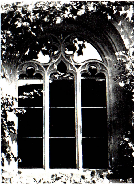
Maßwerkfenster, unter Abt Franz Gaisberg erstellt, reicher gegliedert mit zwei Hohlkehlen im Fensterbogen
