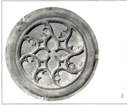
1 Im südlichen Teil des Westkreuzganges, vor dem Gesinde- und Empfangsraum, geben acht Schlußsteine eine Übersicht über die Plan- und Arbeitsweise der Steinmetzen mit Dreieck, Quadrat und Kreis, mit Sechs- und Achteck, mit Stern, Fischblase und Verschlingungen: Auf einfallendem Achteckteppich (Barock!) doppel-schwellende Achteckblätter mit Achteckblume.
