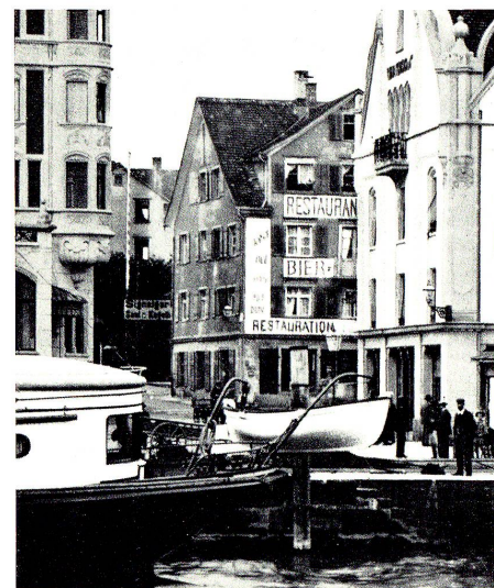
16 Das Signal vor dem Abbruch Photo Labhart
