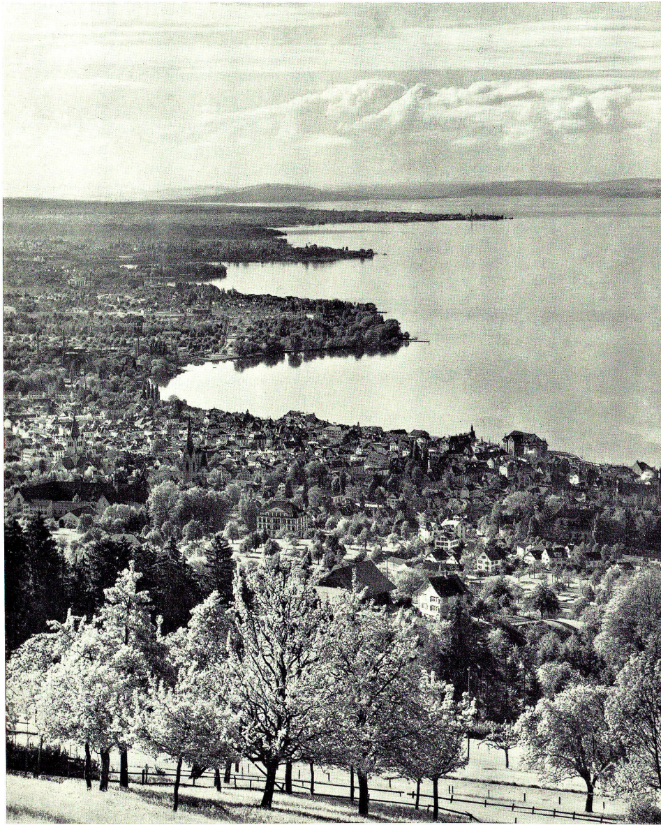
Rorschach, weiter hinten die Buchten von Horn, Arbon und Romanshorn
