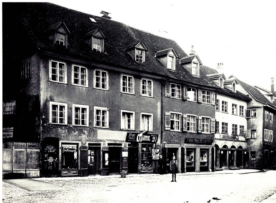
Westliche Hauptstraße, Südseite, vor dem Abbruch 1935. Photo: Labhart, Rorschach.
