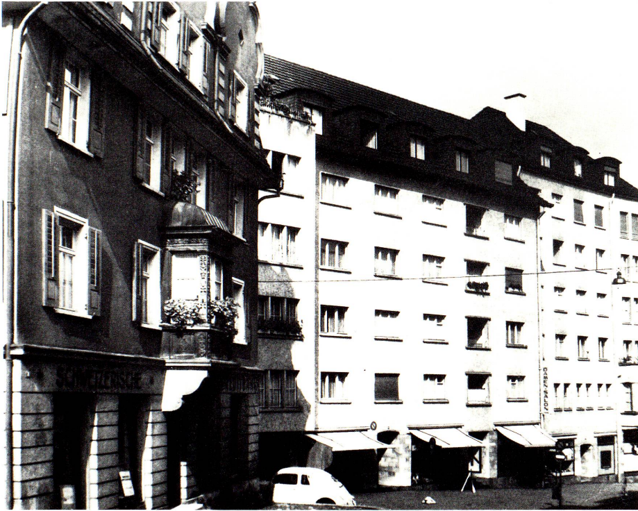
Neubau an der Stelle des Hauses Im Hof, 1948 Photo H. Labhart
