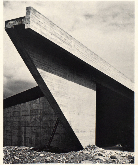
Flügelmauer der Unterführung «Untereggenstrasse». Foto F. Kriegl.
