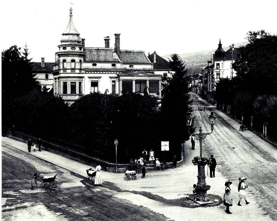
Villa «Monbijou», um 1910, an der Stelle des heutigen Hochhauses (1956). Links St.Gallerstraße, rechts Kirchstraße.
