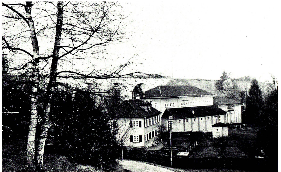
Unterwerk SAK Haldenmühle Im Hintergrund Goldach-Viadukt SBB
