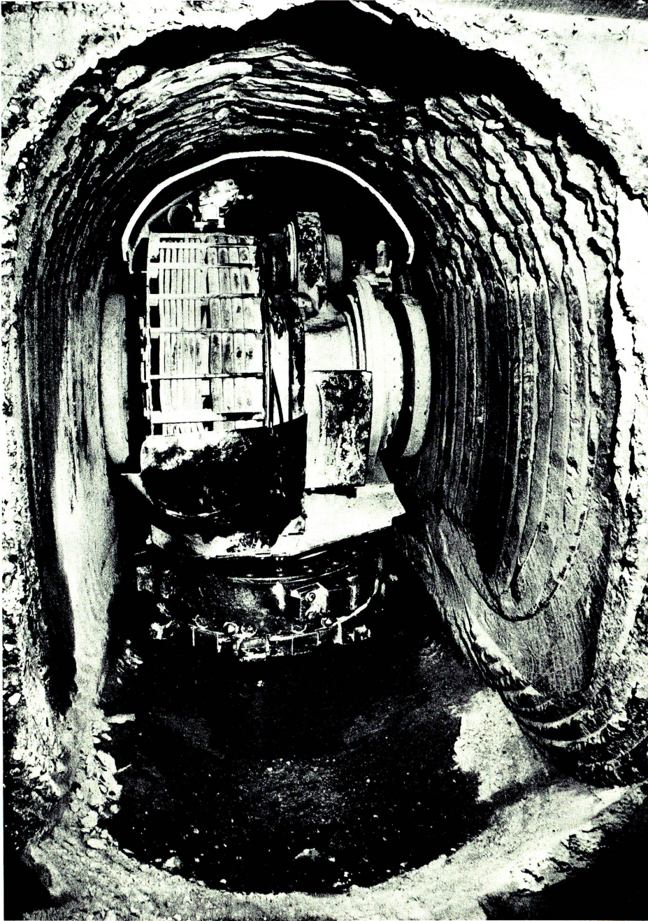
Mini-Stollenfräse nach dem Durchschlag des Querstollens Rorschach-Ost. Photo Grund- und Tiefbau AG, Stäfa.
