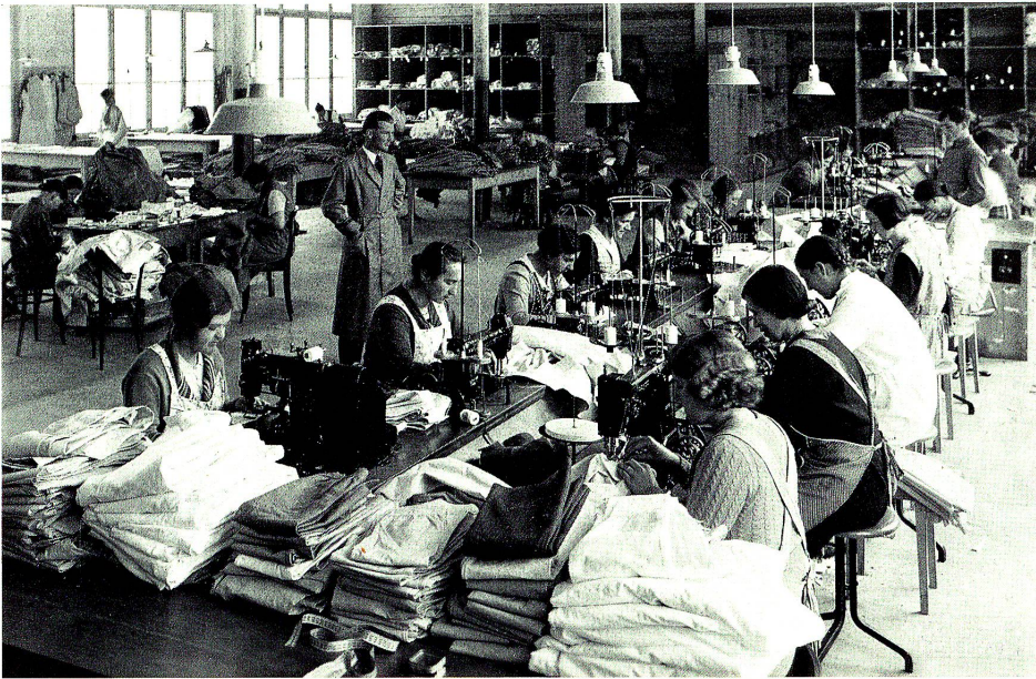
Transita, 1907, an der Bruggmühlestrasse, Stickerei Hättenschwiller-Hautle; Blick in den Nähssaal.
