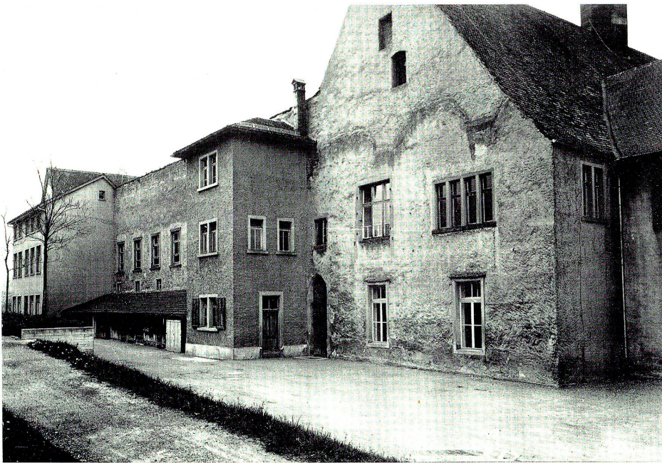
Alter Zustand der Südfassade mit den Anbauten aus dem 19. Jahrhundert.
