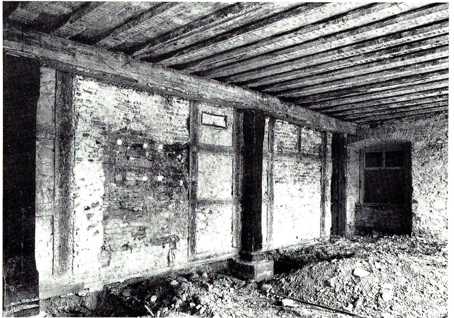
Freilegen der gotischen Holzbalkendecke und geschnitztem Mittelpfeiler der früher zweiachsigen Hallenräume im Obergeschoss Westflügel. Die Gangwand wurde im 19. Jahrhundert eingefügt.
