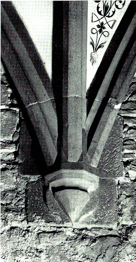
Überarbeiten schadhafter Partien der Rippenkonsolen.
