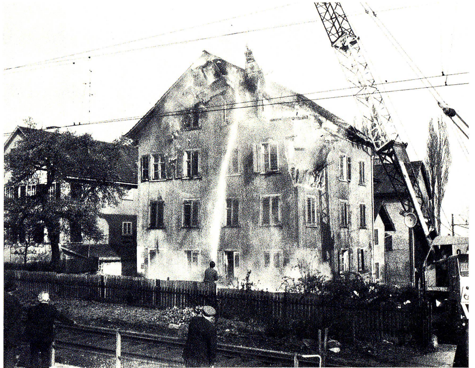
An der Bellevuestrasse in Rorschach mussten zwei baufällig gewordene Häuser, die vom Kanton im Hinblick auf eine bevorstehende Verkehrsanierung erworben wurden, abgebrochen werden. Photo P. Hug.
