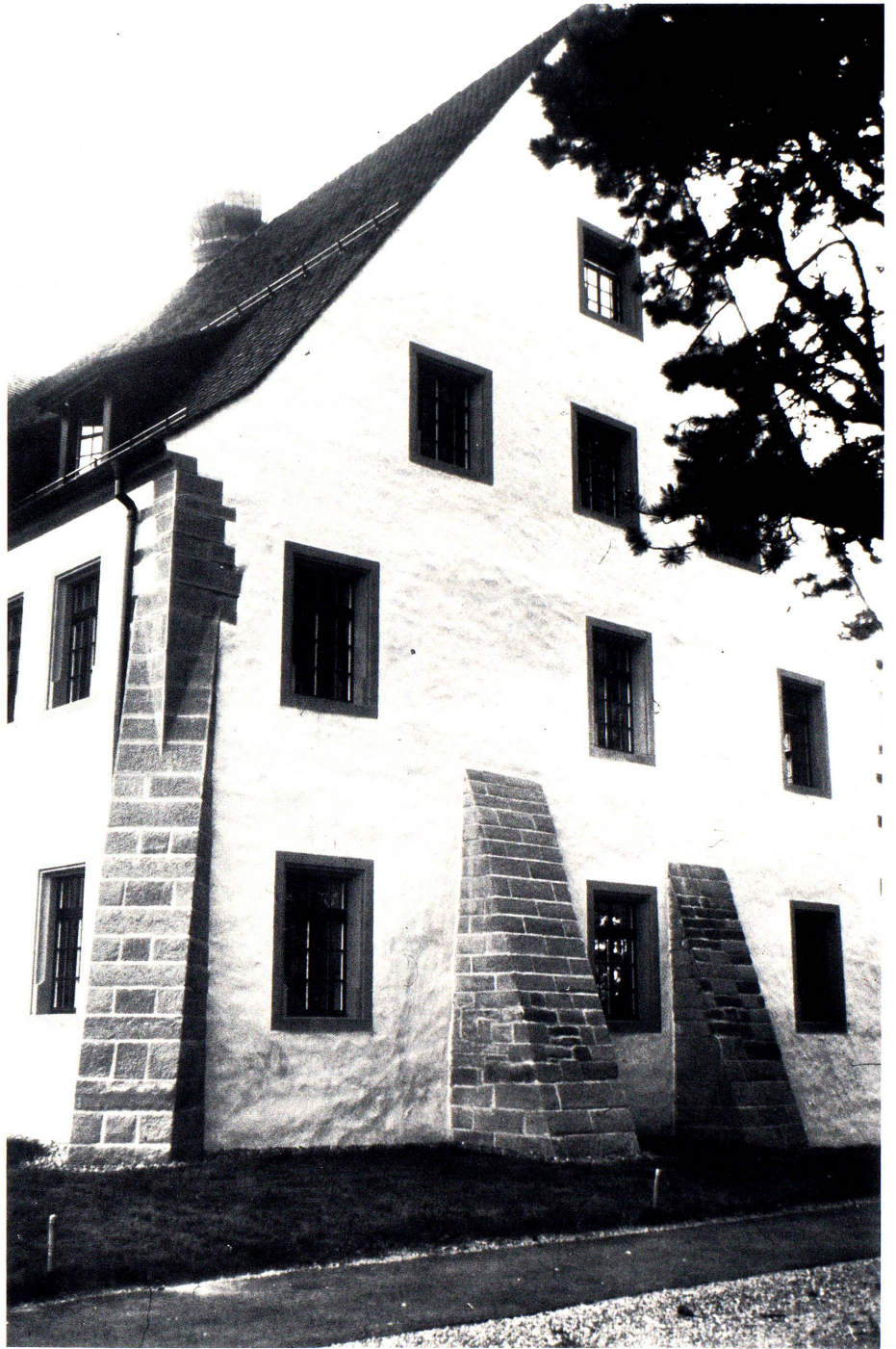
Der restaurierte Ostflügel mit dem neuen, steileren Dach und überarbeiteten Strebepfeilern.
