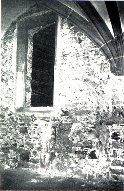
Altes Türgewände im Nordkreuzgang, bisher verdeckt unter Wandputz.
