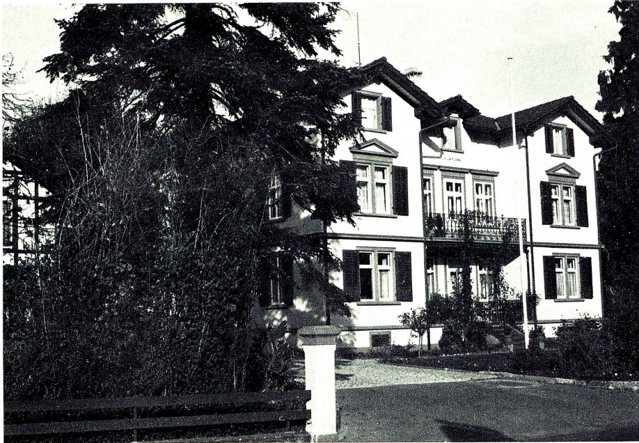
Villa Sol Diario. Von Albert Traber erbaut 1901.
