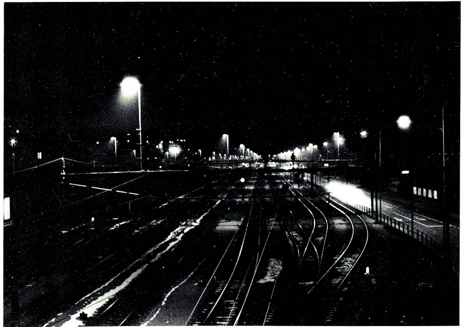
Die Rangieranlage an der Churer Strasse östlich des Rorschacher Hauptbahnhofes bei Nacht. Photo Reto Braun.
