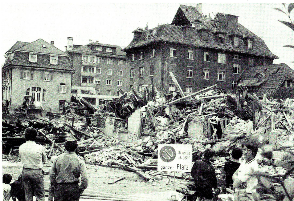
Die Trümmer des abgebrochenen Hotels Casino, dahinter die Pension Blumenau im Abbruch. Beide Gebäude mussten verschwinden, um Platz für das Gemeindezentrum der katholischen Pfarrei Rorschach und den Stadtsaal der politischen Gemeinde Rorschach zu machen. Photo P. Hug.
