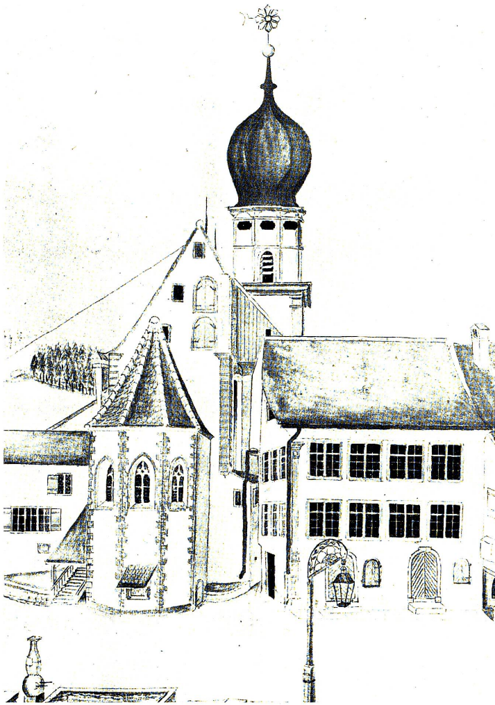
Die Chorpartie der Kirche in Rheineck. Barocker Zustand mit Eckquadrierung des Chors und aufgemalten Pilastern an der Kirche. Noch stehen südlich der Kirche der gedeckte Treppenaufgang, das Pfarrhaus und das angebaute Obertor (nicht mehr sichtbar). Zeichnung von J.M. Künzle 1838 (Privatbesitz Rheineck).
