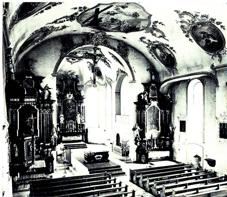
Pfarrkirche in Steinach vor der Restaurierung 1981. Stark verschmutzte Wände und Decke, durchschimmernder Lattenrost wegen fehlender Isolation. Volksaltar um 1970 auf provisorisch vorgezogenem Holzpodium.
