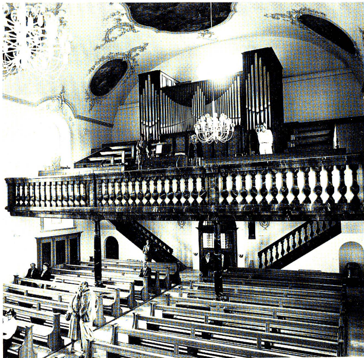
Brüstungen der Empore und Aufgänge nach Grubenmannschem Muster 1981 neu gestaltet, Orgelprospekt von 1953; Windfang zurückgestuft und formal integriert.
