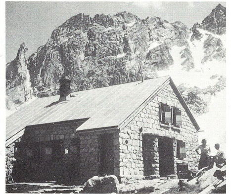
Nach Plänen und unter der Leitung von Hans Moser wurde 1933/34 eine Erweiterung der Hütte vorgenommen, die fast einem Neubau gleichkam und das Platzangebot auf 48 erhöhte.
