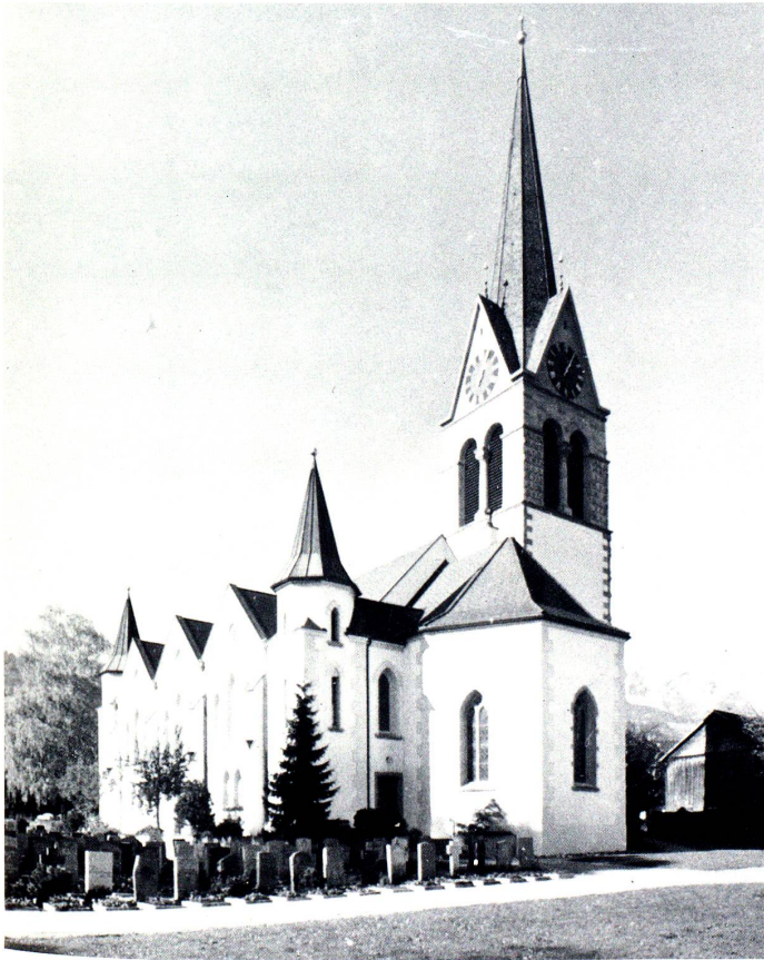
Grabs, ev.-ref. Kirche von Südosten. Spätgotischer Chor, Schiff 1901, Turm 1917 neu gebaut.
