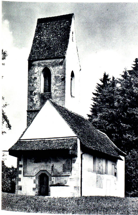
Jona, Kirche St.Dionys. Spätgotischer Bau mit Aussenfresken, 3. Viertel 15. Jahrhundert. Zustand vor der Aussenrestaurierung 1987.
