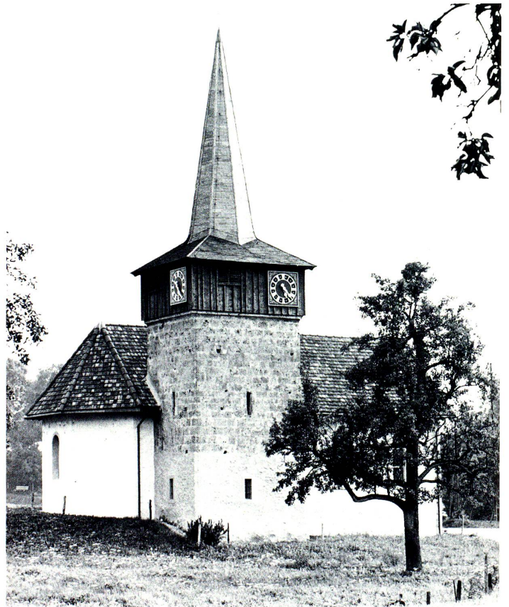
Lütisburg, Kapelle St. Fridolin in Tufertschwil. Spätgotischer Bau mit Turm, der ein gezimmertes Glockengeschoss trägt; Pyramide 1891.
