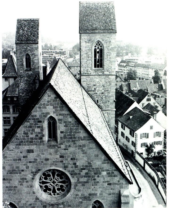
Rapperswil, Pfarrkirche St.Johann. Kleiner romanischer Turm mit gotischem Glocken- geschoss, grosser Turm 1441 ff., Schiff und Chor neugebaut 1883–85.
