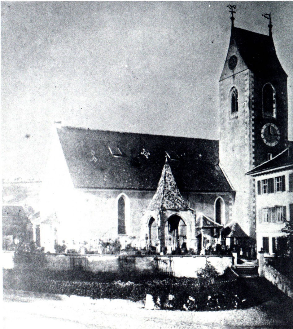
Thal, paritätische Pfarrkirche. Südansicht der Anlage vor Abbruch der Ölbergkapelle 1870 und des Turms 1904.
