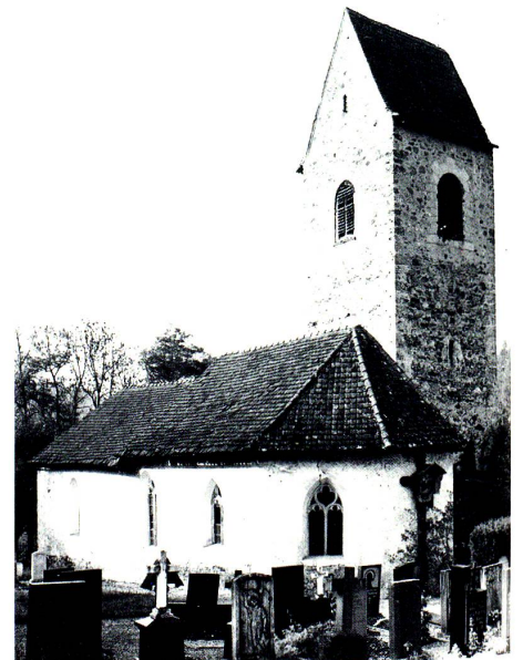
Degersheim, alte Pfarrkirche St. Verena in Magdenau. Zustand vor der Restaurierung 1968. Gut sichtbar die Turmerhöhung von 1675.
