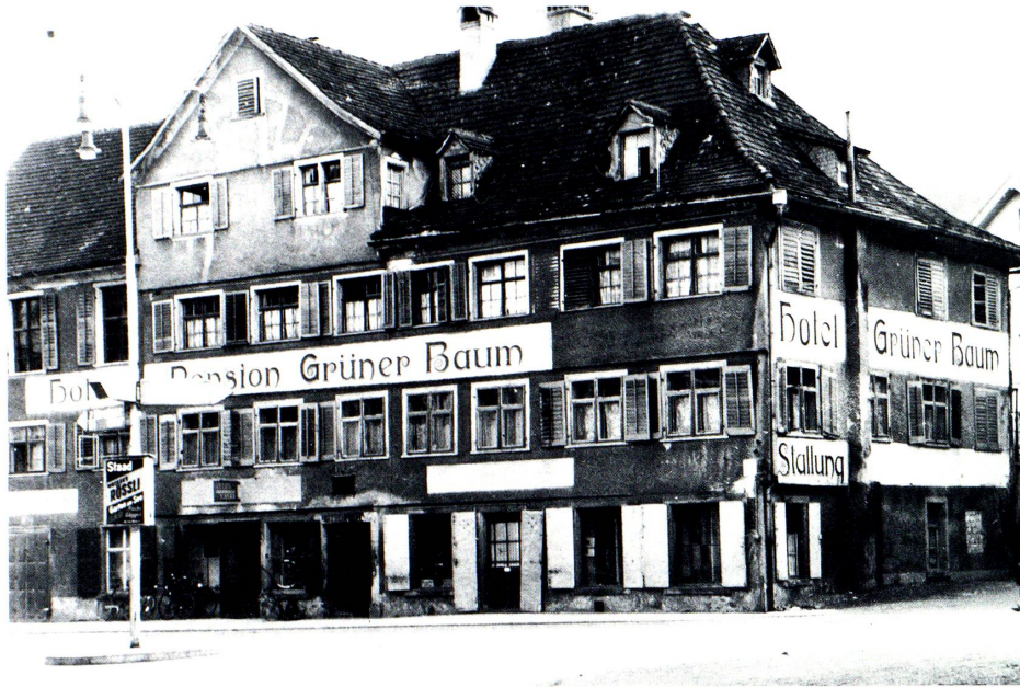
Das baufällige Hotel «Grüner Baum» am Bodanplatz. Abbruch 1950. Fotoarchiv Josef Göldi.
