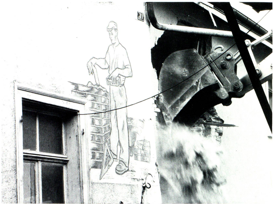
Häuserabbruch an der Simonstrasse Rorschach. Ein grosses Mehrfamilienhaus ist im Bau. Fotos Daniel J. Stieger.
