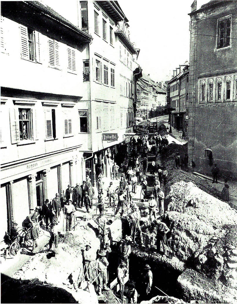
Der Bau der Kanalisation in Ravensburg um 1900
